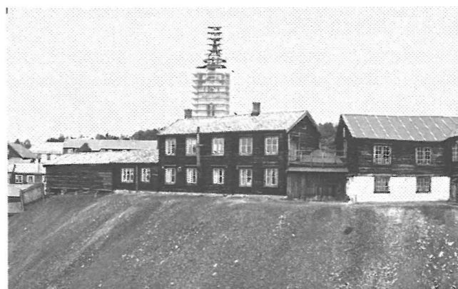
Utsikt över Röros från slagghögarna. Kyrkan under renovering. Foto: Kristina Torén
